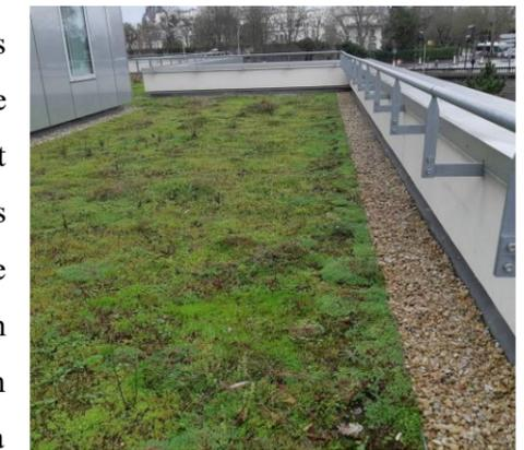
Figure 125: Photo d'une toiture végétalisée.
