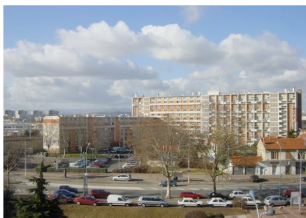
Figure 3 : Exemple des anciens habitats de Mermoz Nord. Source : Projet de rénovation urbaine du quartier de Mermoz Nord, Lyon 8ème Dossier d'Opération Juin 2006
