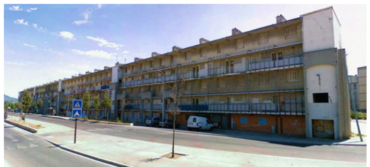
Figure 13 : Photo de la banane avant intervention. Source : http://la-seyne.info.free.fr
