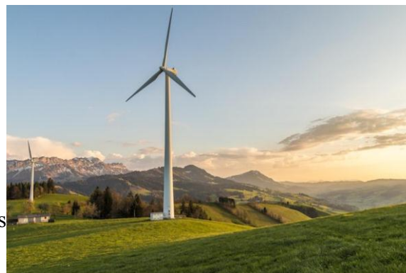
L'utilisation de L'énergie éolienne source: site web : en lumière
