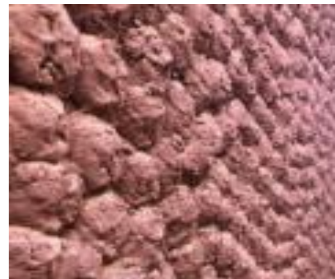
Technique de tbolit Source : Google image
