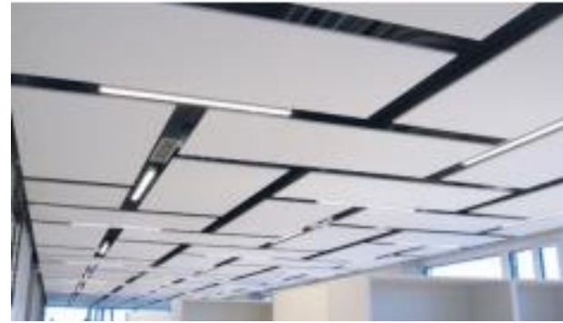
Figure 32: Faux plafond Source : www.solutionacoustique.com
