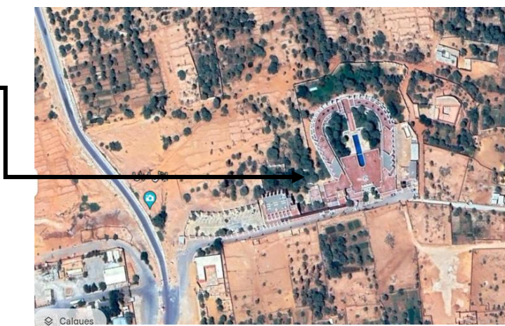
Figure 57:vue aérienne de l'hôtel, source : Google earth
