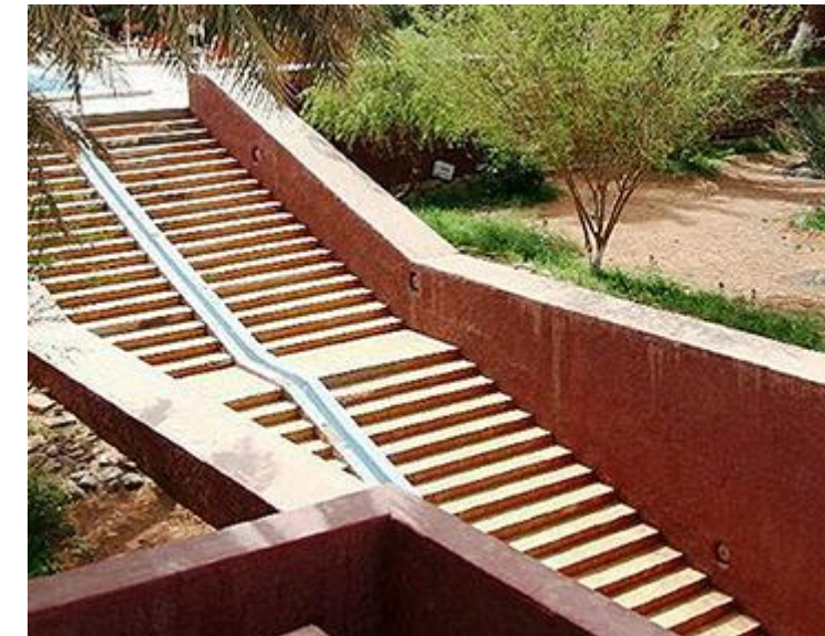
Figure 67: vue sur escalier hôtel Gourara , source : google
