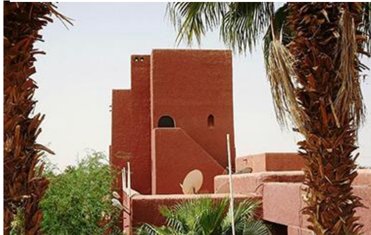
Figure 71::vue sur le mur massif ,source : google
