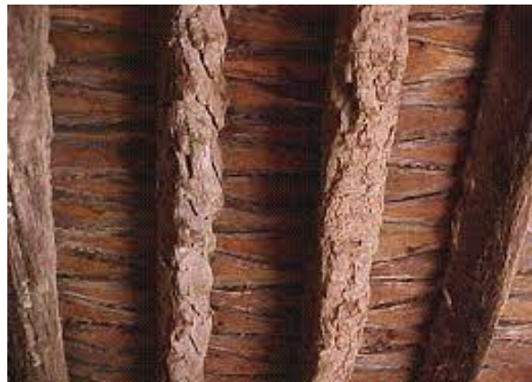
Figure 29:système constructif des ksours.
