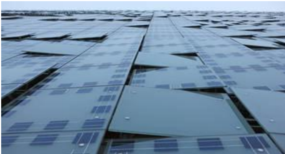
Figure 41: Façade du bâtiment Greenpix et utilisation de cellules solaires.
