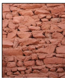
Figure 84: La construction en brique cru et pierre à Ighzer. /Source: SADOUNE.L, 2024.
