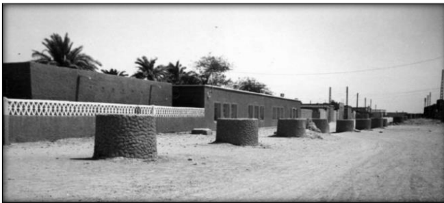
Figure 32: Puits d'aération. /Source: Remini, 2008.
