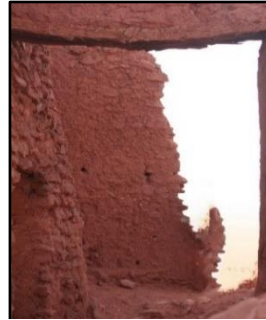
Figure 71: Issue de secours. / Source: auteur SADOUNE.L, 2024.
