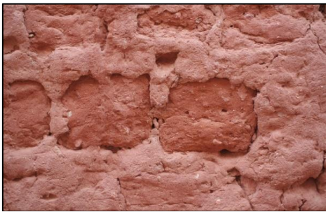
Figure 84: La construction en brique cru et pierre à Ighzer. /Source: SADOUNE.L, 2024.
