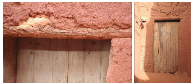
Figure 85: Bois utilisé au niveau des portes. /Source: auteur SADOUNE.L, 2024.
