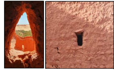
Figure 91: Formes d'ouvertures à Ighzer. /Source: auteur SADOUNE.L, 2024.
