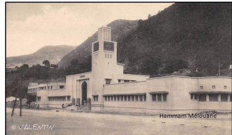
Figure 67. Hammam Melouane avant la rénovation. Source : Google image.
