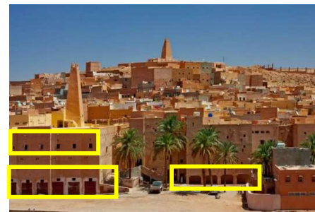
Figure 58 Façade du Ksar El Atteuf source
