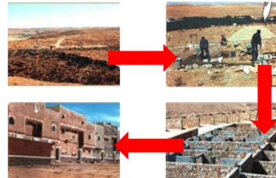
Figure 29 La pierre locale, matériau de base Du ksar de Tafilelt
