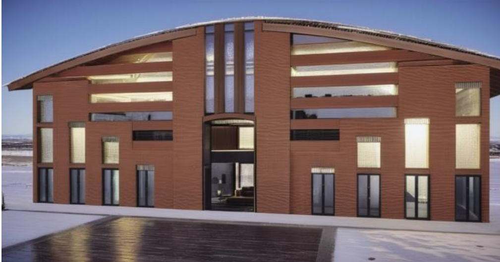
Figure 185: Vue sur la façade principale
