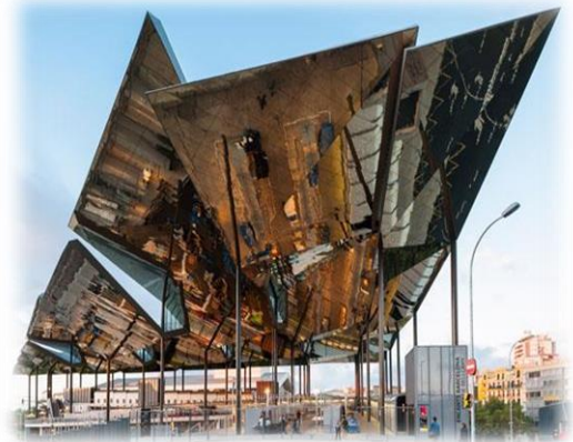
Figure 22: Vue sur toiture du marché
