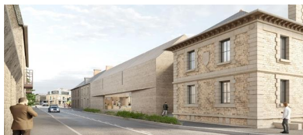
Figure 27 : Vue extérieure du CIAP
