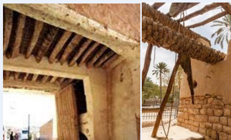
Figure comme des poutrelles98 : le palmier ; Figure comme des poutres99 : le stipe utili ;
