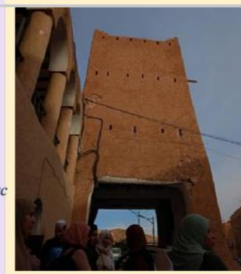
Figure 145 bordj du ksar beni isguen source : fait par auteur
