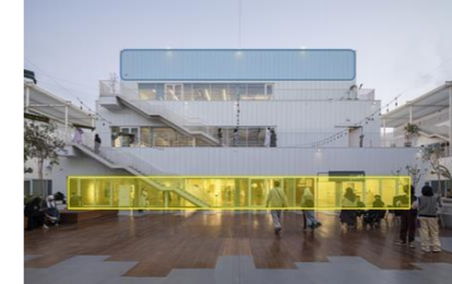
Figure 16 : Façade est-ouest de centre culturel Hayy Jameel ; Source : https://www.archdaily.com/?ad_name=smalllogo traité par ABID.H
