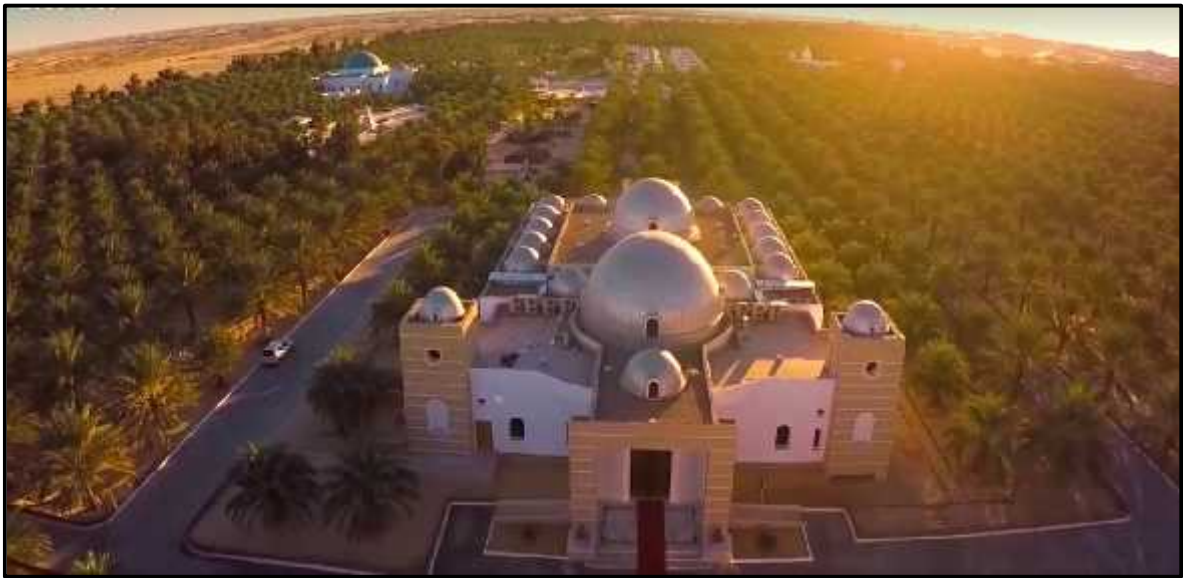
Figure 65 : Vue aérienne sur le complexe la Gazelle d'or Source : http://dia.algerie.com .
