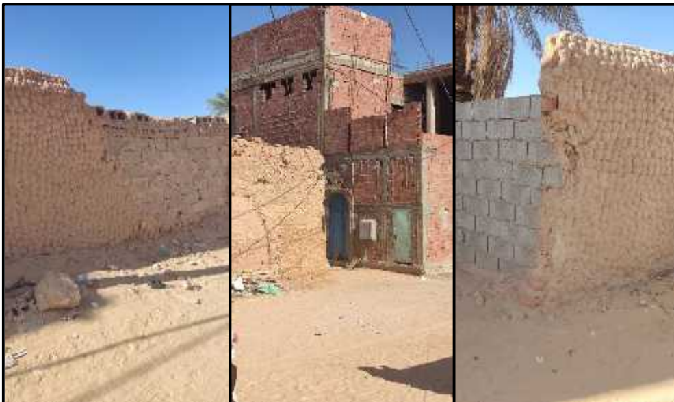
Figure 125 : État du bâti dans la zone d'intervention Source : Auteur 2024
