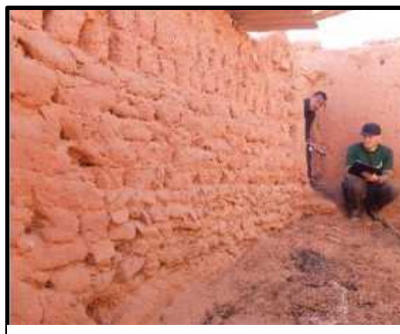
Fig 22 : Mur en briques d'adobe
