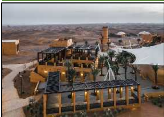
Figure 60 : vue aérienne sur les arcades Source : www.Archdaily.com
