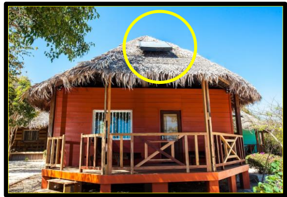
Figure 55 : les panneaux solaires sur la toiture
