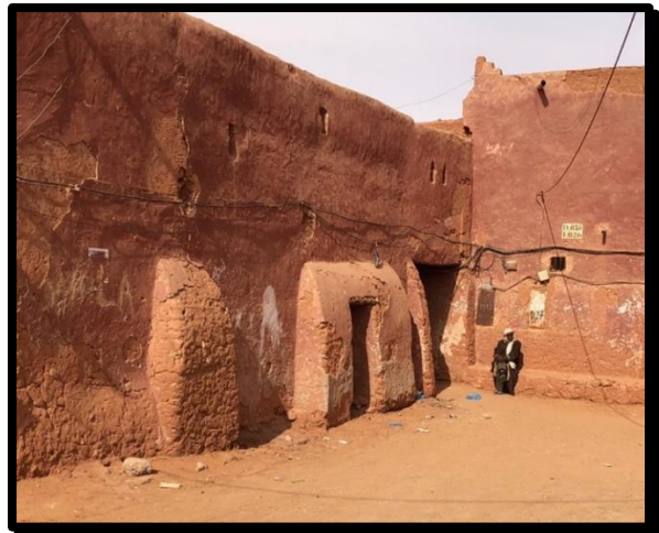
Figure 119:le contrefort d'une maison
