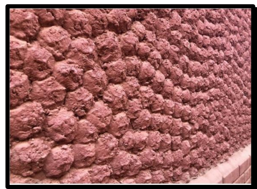
Figure 131: enduit d'une façade
