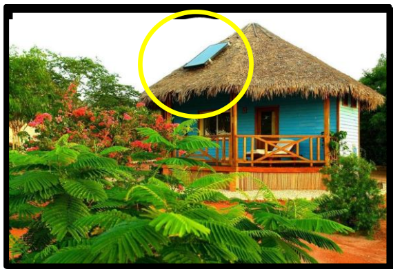
Figure 54 : les panneaux solaires sur la toiture
