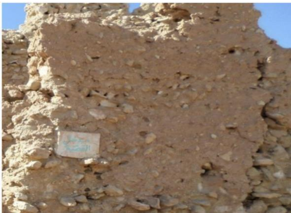
Figure 90 Composition des murs du ksar
