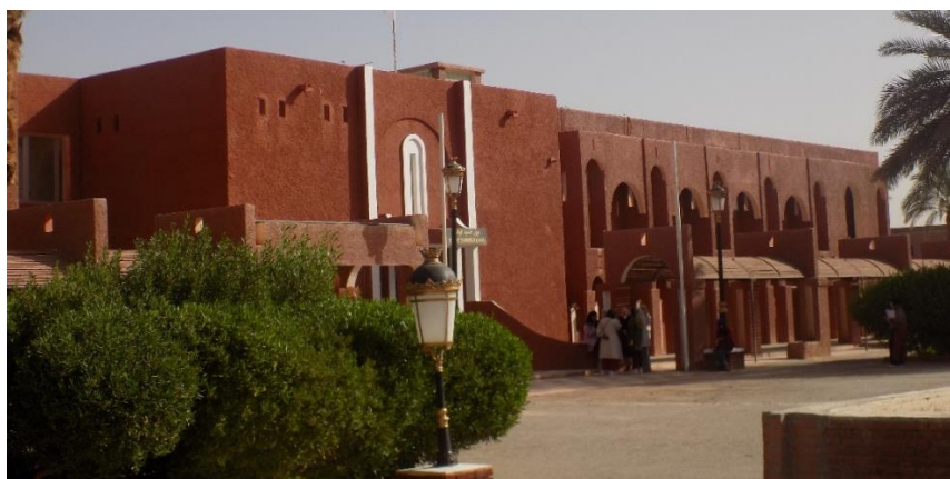
Figure 71 Siège de la Wilaya d'Adrar, source : auteur
