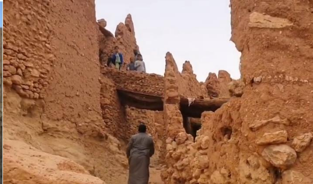
Figure 87 Le pont de l'entrée de la Casbah vue d'en bas
