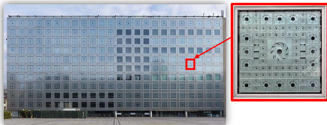
Figure 53 Façade sud de l'IMA, source : Les 240 moucharabiehs de l'Institut du monde arabe (lemoniteur.fr)
