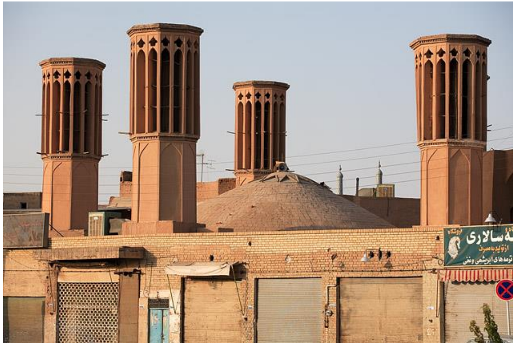
Figure 7 Badgir (tour de vent) exemple de solution au zones arides à Yazd, Iran, source : https://www.albert-videt.eu/photographie/carnet-de-route/iran_10-2006/badgir_tour-du-vent_yazd_03.php
