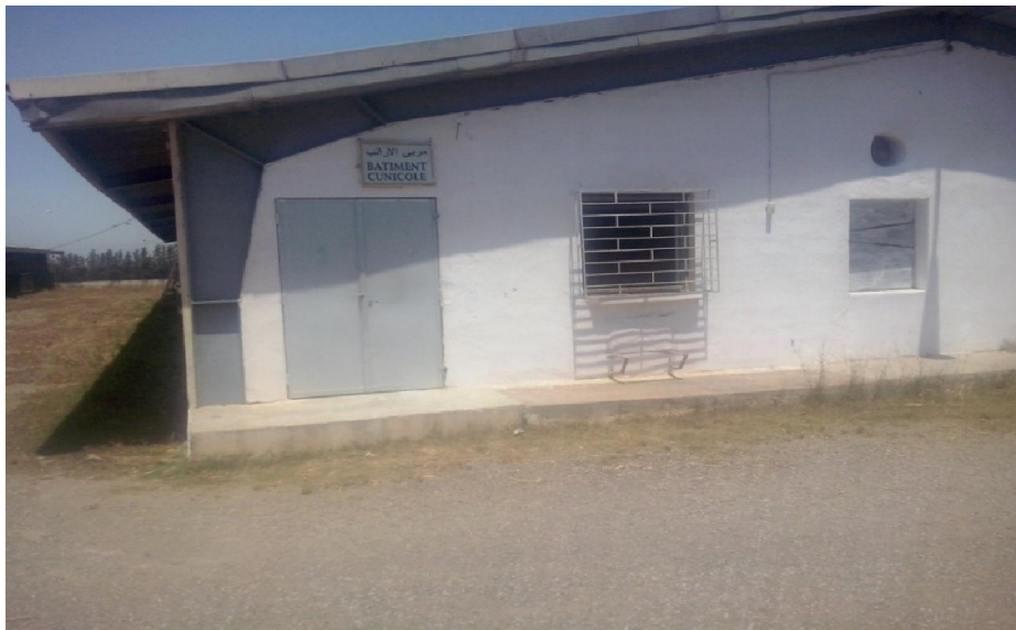
Figure 08 : Bâtiment d'élevage cunicole (Photo personnelle)
