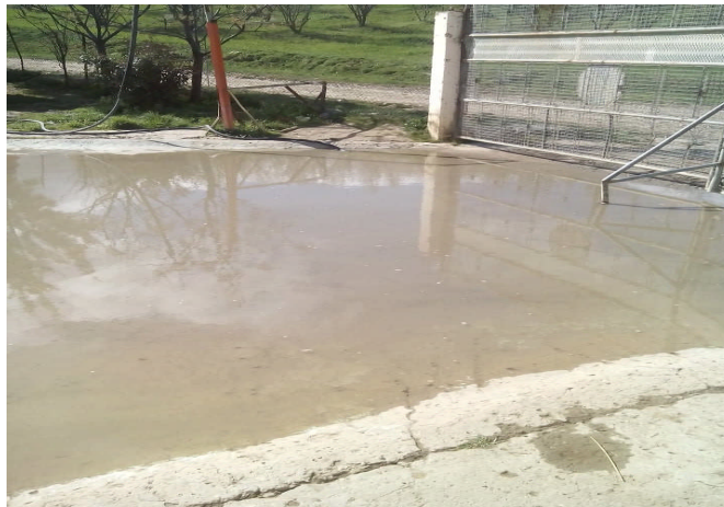
Figure 4 : Rotloluve à l'entrée du bâtiment.
