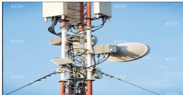
Figure III.9 : exemples d'une antenne sectorielle [30]
