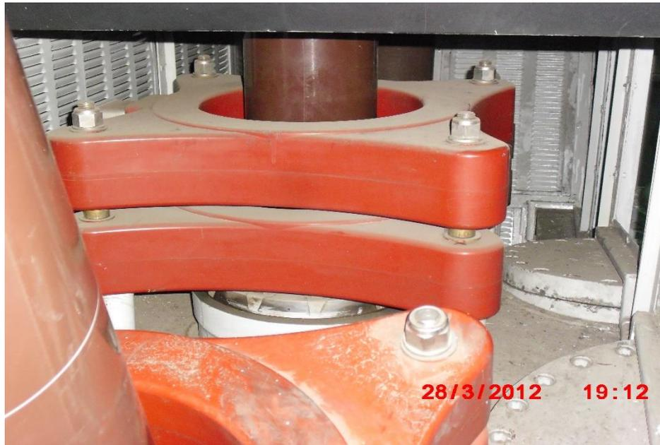
Figure 2.7 : Transformateurs de courant placés sur l'une des bornes de l'alternateur. [6]
