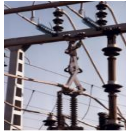
Figure II.26 : Sectionneur pantographe
