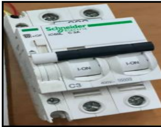
Figure 2 : Disjoncteur bipolaire avec contact auxiliaire
