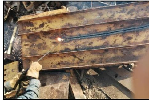
Figure II-7: Le cisaille par la soudure chalumeau
