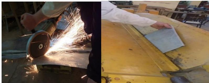
**Figure IV. 30:**Découpage et pliage de la tôle
