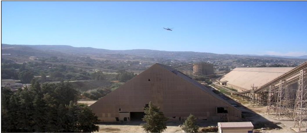
Figure I.5 : Hall de pré homogénéisation.
