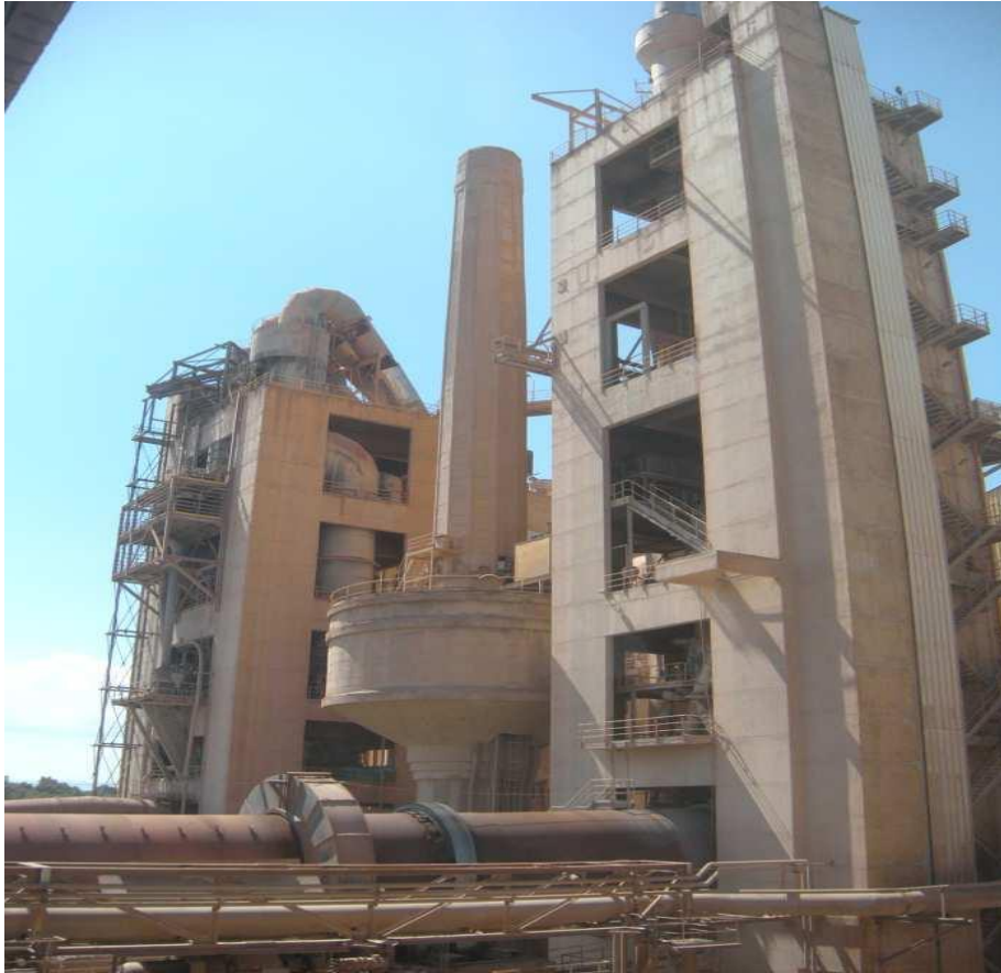
Figure II.1 : filtre à manches vue d'extérieure.
