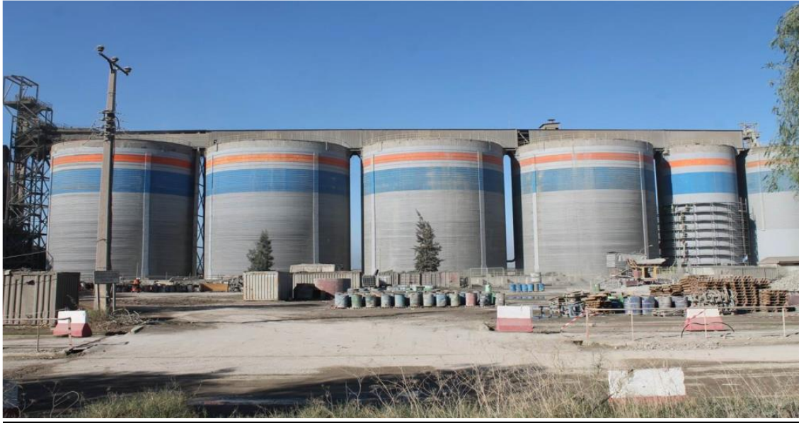
Figure I.10 : Silos de stockage du clinker, gypse et tuf.
