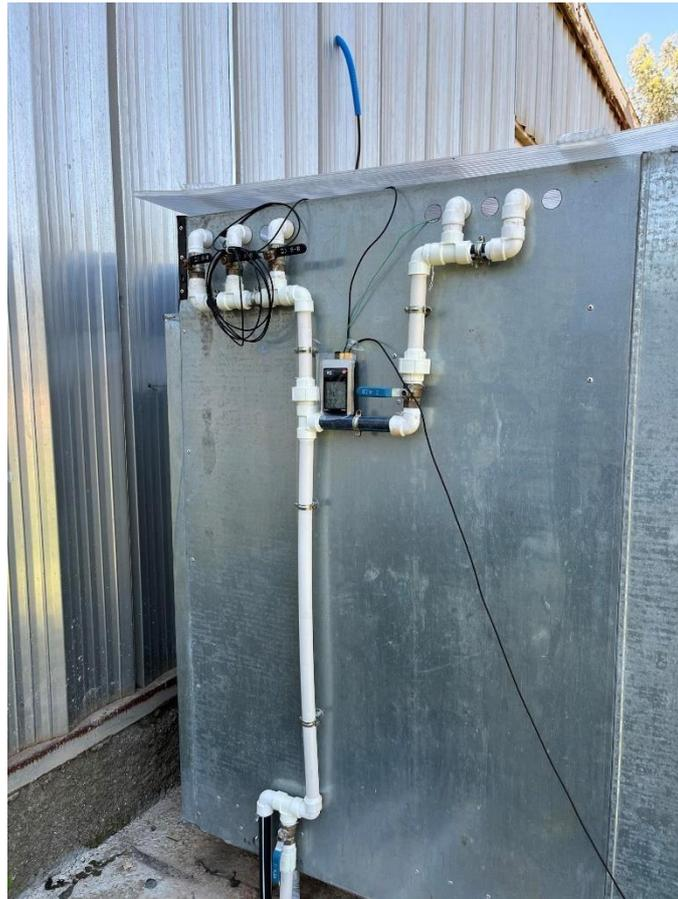
**Figure 3.13 : Placement de thermocouple au milieu ambiant**
