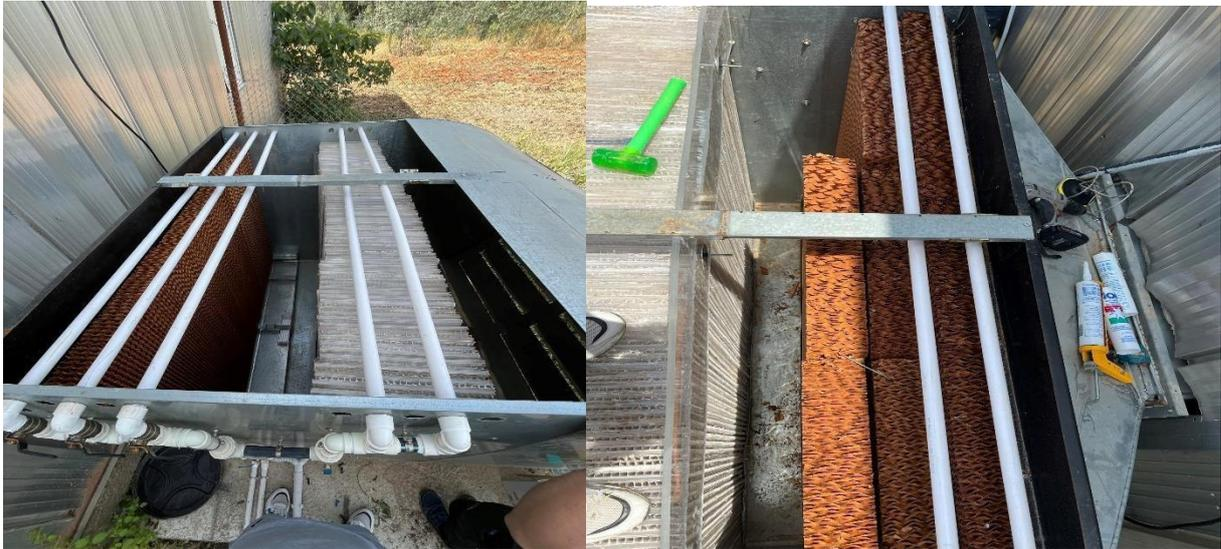
**Figure3.4 : Placement des pads en cellulose**
