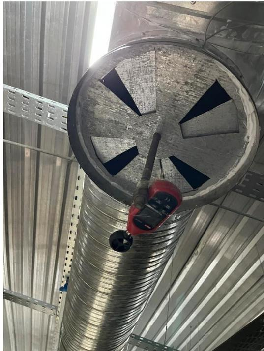
**Figure3.14** : Emplacement de l'anémomètre.
