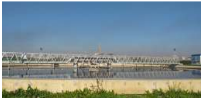
Figure 5 : Un clarificateur circulaire de STEP de Baraki (photo original)
