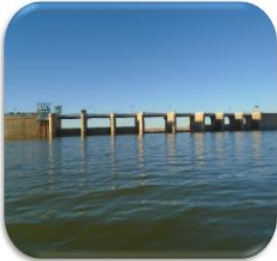
Le déversoir du barrage
