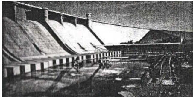
Fig. 2 : Barrage de Djorf Torba en cours de construction en 1968 (Anonyme A).
