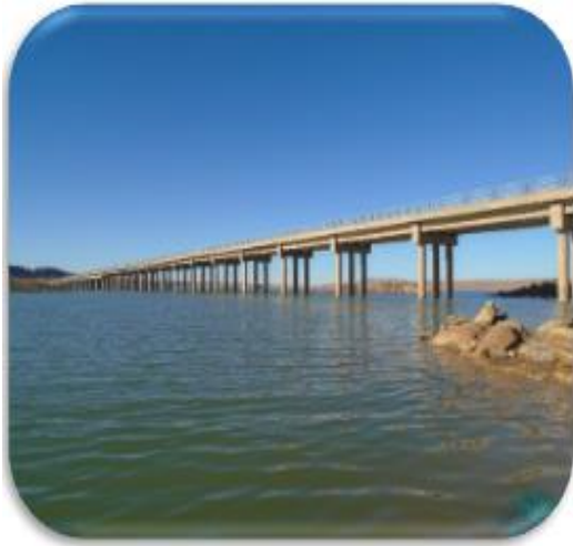
L'amont du barrage
