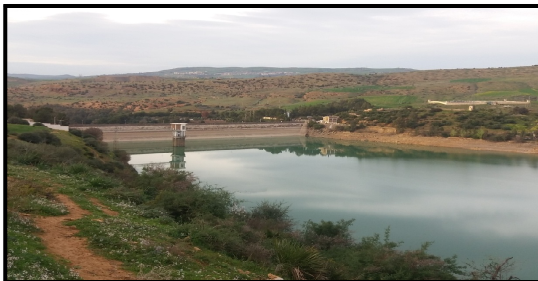
Figure. 5 : Photo réelle du barrage Ghrib .
