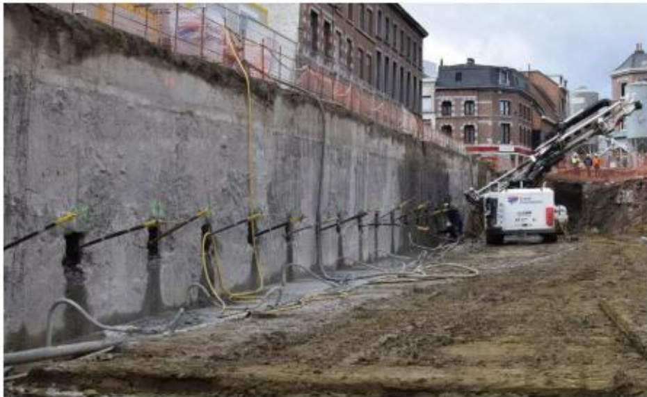
Figure I.11: Paroi avec tirants d'ancrages.
