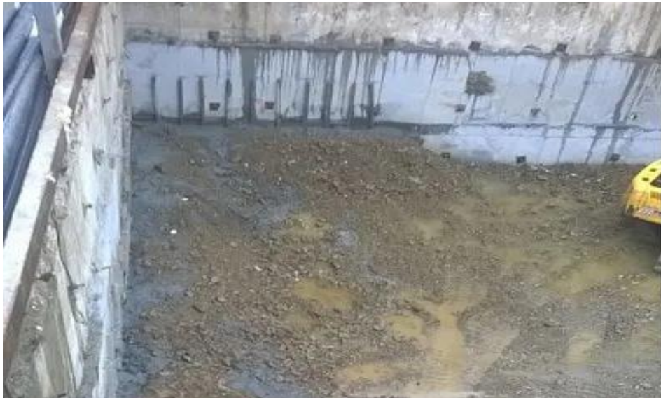
Figure I.2: Excavation à ciel ouvert en porte-à-faux.
