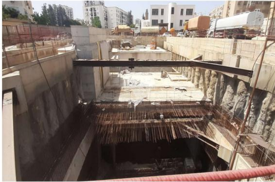
Figure I.10: Pieux avec butons.
