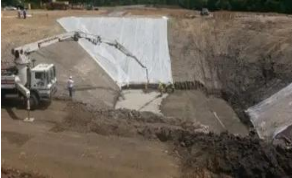
Figure I.1: Excavation à ciel ouvert en pente.
