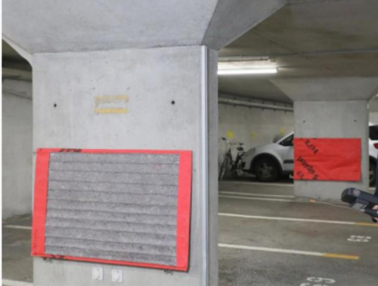
Figure II. 22 Des capteurs thermiques pour stocker la chaleur dégagée dans les parkings
