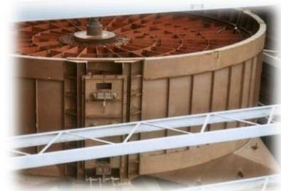
Figure III- 11 : Échangeur à lit Figure III- 10: Échangeur rotatif Figure III- 12 : Aérateur réfrigérant
