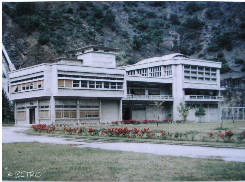
Figure 62 : Vue sur le bâtiment de commande de l'usine. (Source : Archives SPE Darguinah)
