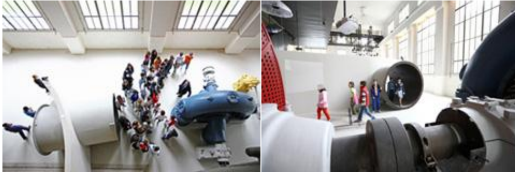
Figures 19 et 20 : Le passage dans le conduit forcé. (Source : Web: http://www.musilcedegolo.it )
