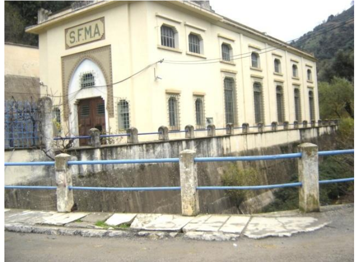
Figure 50 : Vue sur la centrale de Boghni. (Source : Archives SPE Darguinah)
