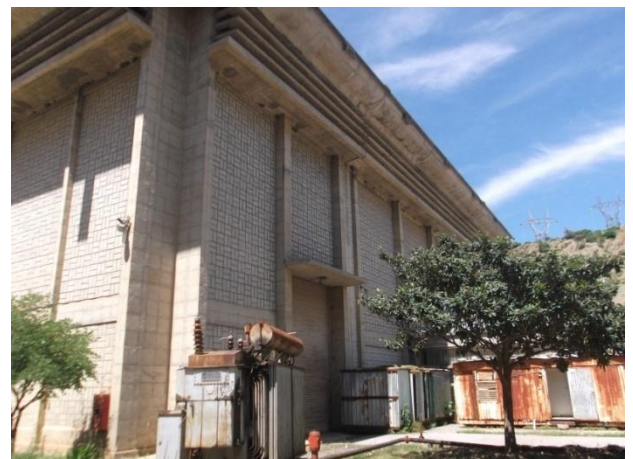
Figure 57 : Vue sur le bâtiment de décuvage de l'usine. (Source : Auteur)
