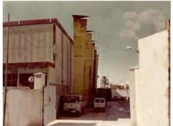
Figure 48 : Vue de la centrale de Laghouat après l'attentat de l'ALN. (Source : http://sidielhadjaissa.over-blog.com/2015/08/la-centrale-electrique-de-laghouat-entre-le-passe-et-le-present-par-a-abdelali.html )
