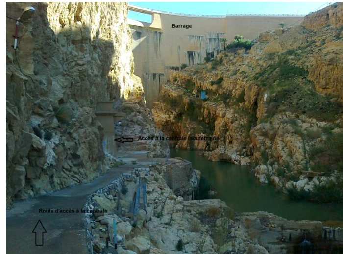
Figure 52 : Vue sur le barrage Foum El Gherza. (Source : Archives SPE Darguinah)
