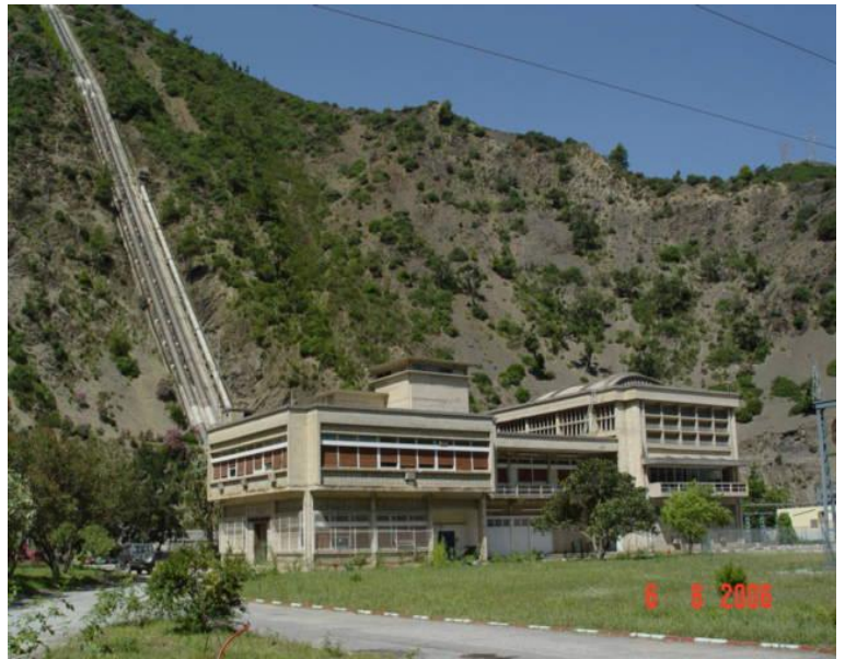
Figure 55 : l'axialité des conduites forcées répercutée sur le bâtiment de commande de l'usine. (Source : Archives SPE Darguinah)
