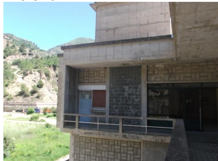
Figure 70 : La façade côté plateforme du bâtiment de commande. (Source : Auteur)
