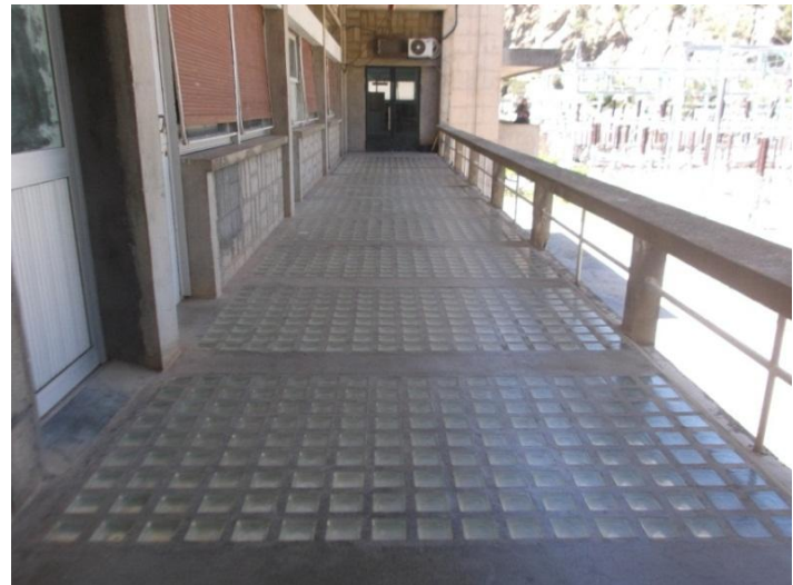
Figure 69 : Le carrelage en briques Nevada de la galerie qui donne sur la plateforme. (Source : Auteur)
