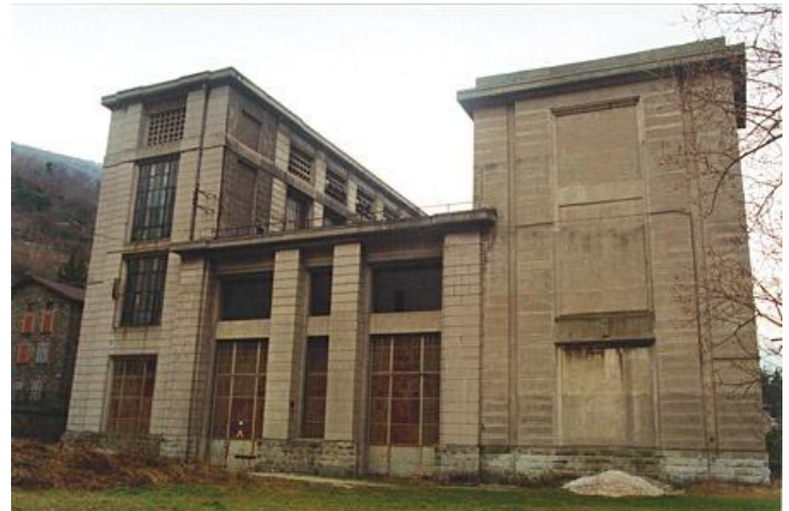
Figure 12 : L'usine de Cedegolo avant l'intervention de récupération.
