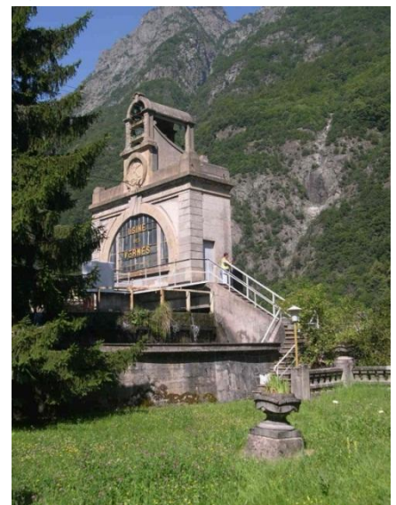
Figure 26: Vue du fronton de la centrale avec le cartouche Keller (source : www.isere-patrimoine.fr )
