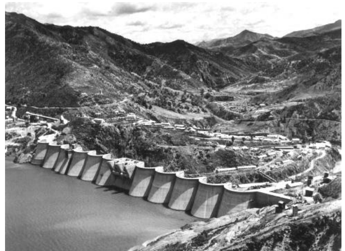
Figure 45 : Barrage Erraguène lors de sa construction. (Source : Archives SPE Darguinah)
