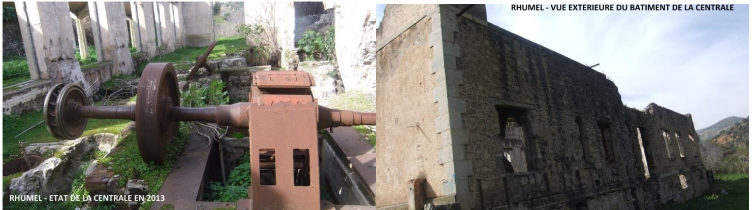
Figures 35 et 36 : Bâtiment et équipement de la centrale Rhumel à Constantine, L'état en ruine année 2013. (Source : Archives SPE Darguinah)
