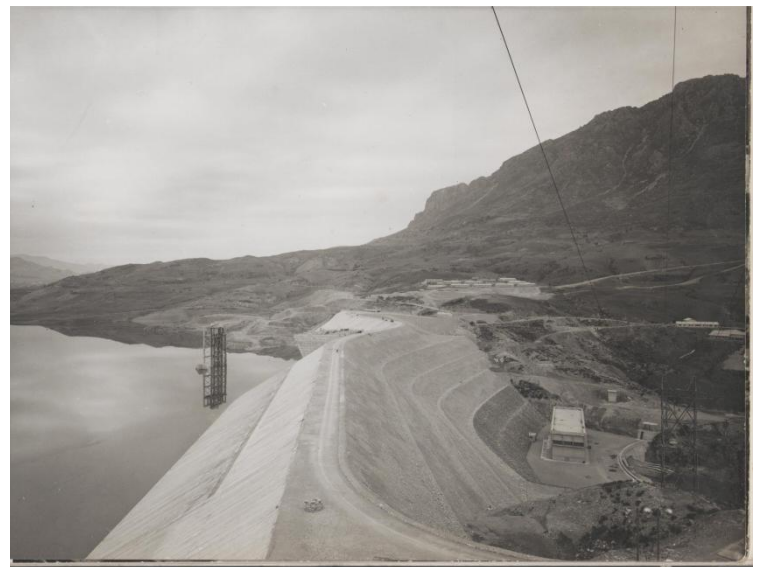
Figure 40 : Le barrage Ighil Emda dans les années 1950.
