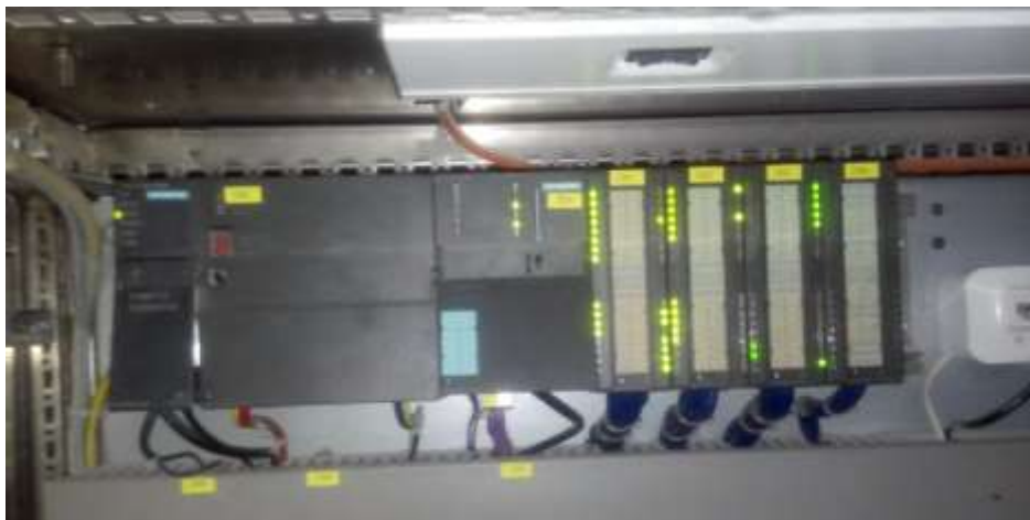
Figure 2.7 Automate programmable S7 300 avec CPU 314. [8]
