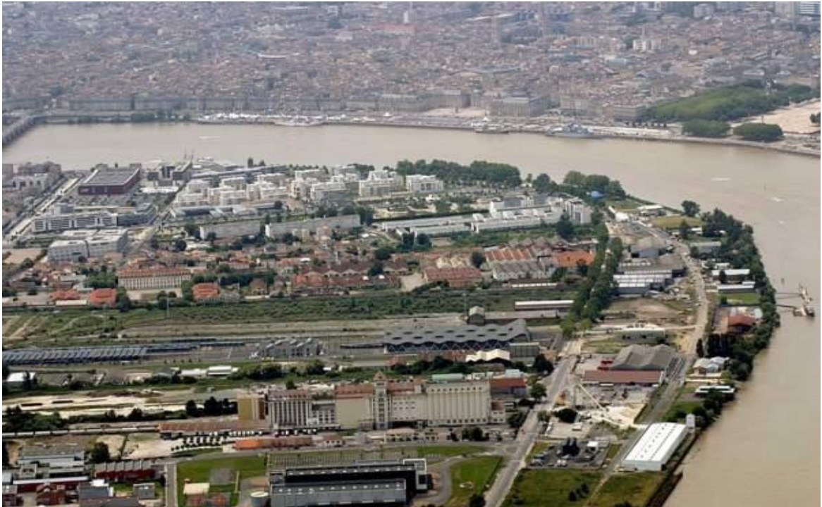
Figure 16 Photo aérienne du Projet Bastide Niel Bordeaux
