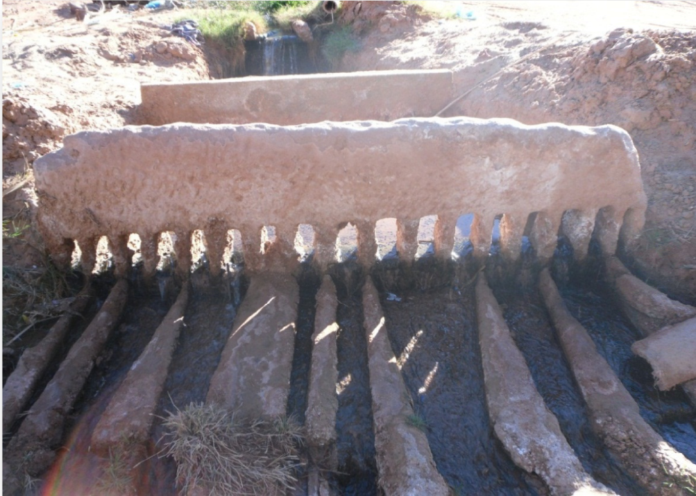
Fig.1.10.Kasria secondaire de foggara d'El Meghier de l'oasis de Timimoun
