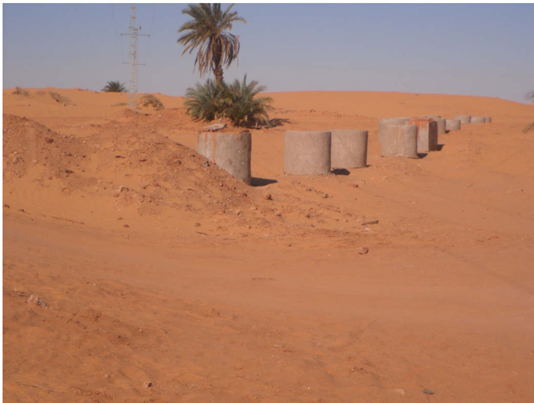
Fig.3.3.Ensablement d'une foggara dans la région de Timimoun
