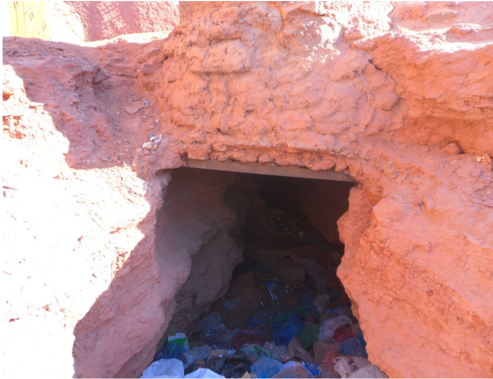
Fig.3.10. Rejets urbains dans la galerie de la foggara Ifli Amokrane de Timimoun
