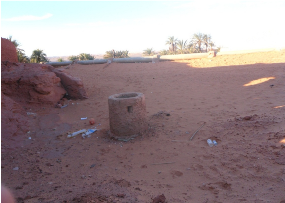
Fig. 3.12. Croisement d'un réseau d'assainissement avec la galerie de la Foggara de La Selma
