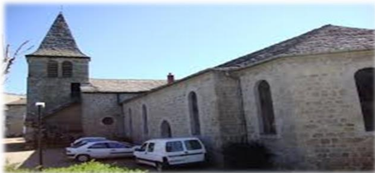
Figure 2.40 Eglise de Lignon
