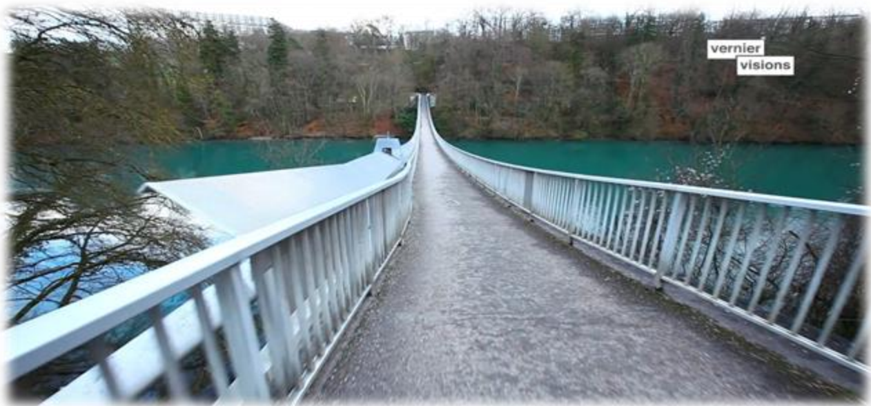
Figure 2.32 Passerelle du Lignon, Vernier, Suisse
