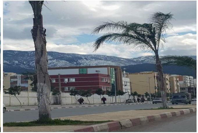
figure 1.8 : université saad dahlab ,un mur de clôture dans un axe très important.
