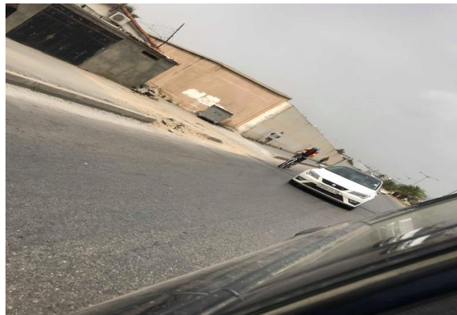
Figure 1.11 : khrouba alger mur de clôture sur un axe très Important
