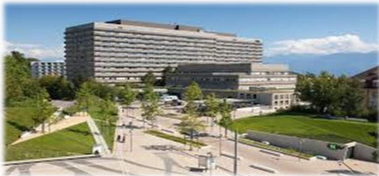
Figure 2.20 Centre hospitalier du quartier
