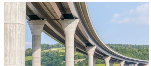
FIGURE 158. POUTRE EN BÉTON PRÉCONTRAIT Source : Archi Expo 2018
