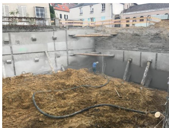
Fig 81: Voiles en béton armé.
