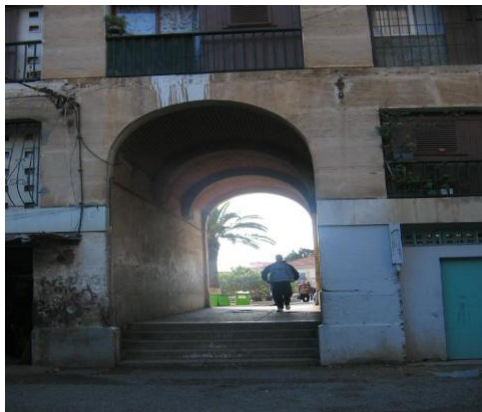
Figure 36 : photo de passerelle Source : Google image
