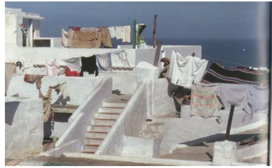
Figure 41 : toit de terrasse Source : Google image
