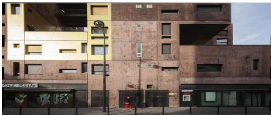
Figure 26 : Vue sur la façade sud Source : www. architizer.com
