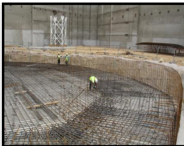
Figure79 : fondation en radier en travaux
