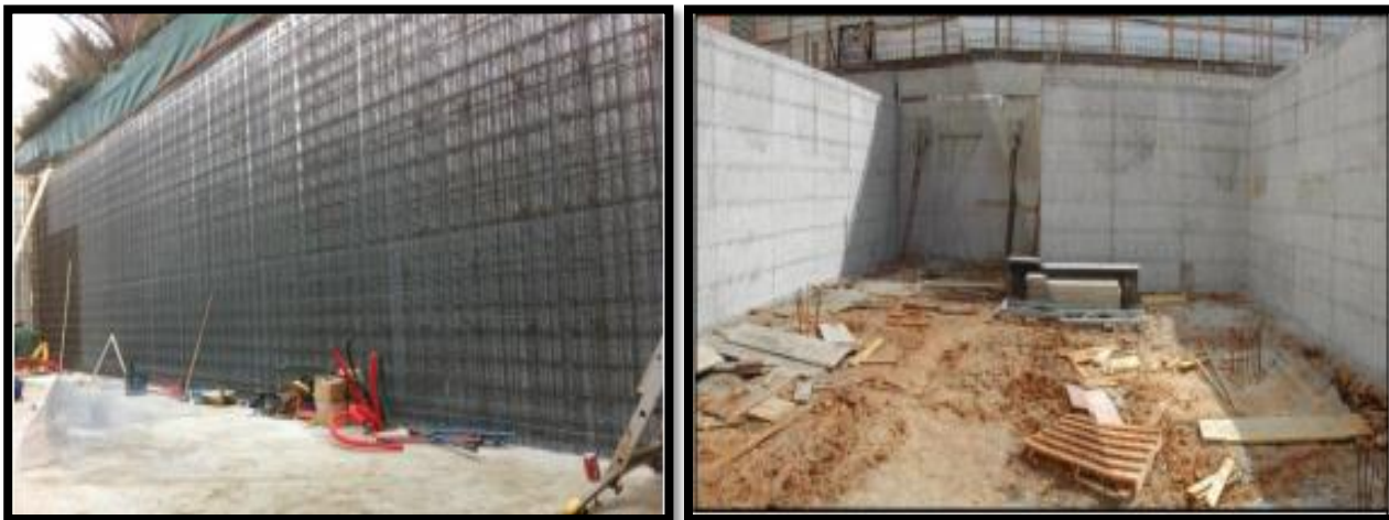
Figure 73 : Mur de soutènements
