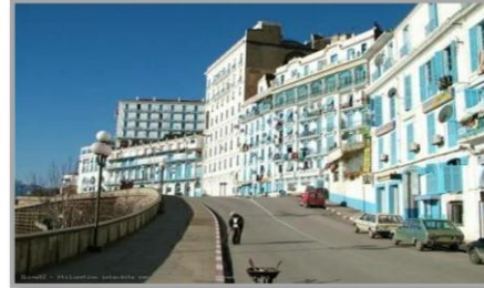
Fig.1.52 : façade maritime de la ville de Bejaïa, Algérie
