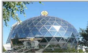
Fig.3.39: exemple de couvertures
