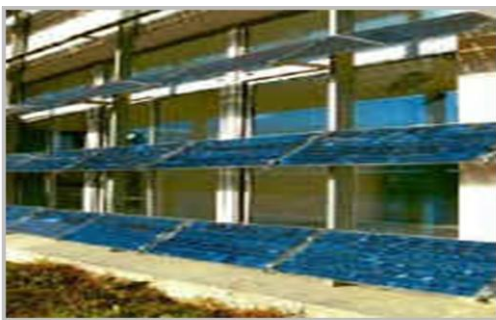
Fig.1.34 : ex d'une brise soleil
