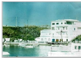
Fig.2.85 : l' Ancien restaurant le sauveur.
