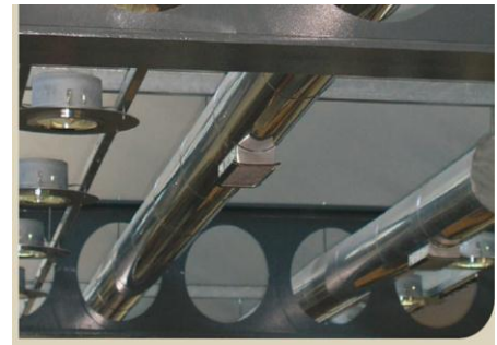
Fig.3.34: exemple d'une poutre alvéolaire
