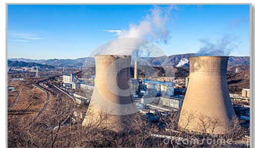
Fig.1.15 : tour de refroidissement d'usine d'industrie lourde à Pékin
