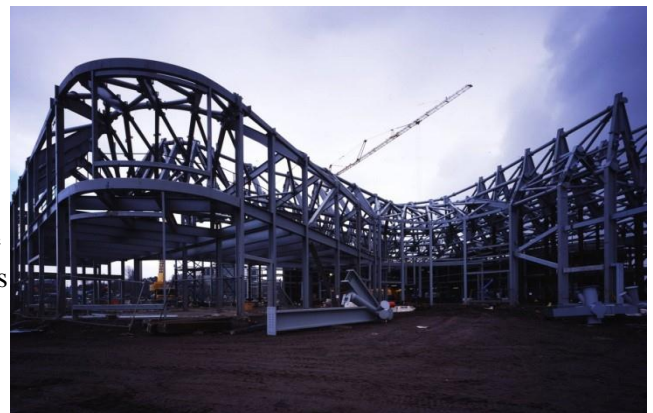
Fig.1.67 Structure de Musée Riverside Glasgow
