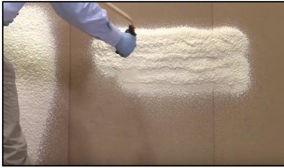
Fig107 Utilisation de PU sur les murs source https://www.kit-mousse-isolation.com/products/kit-froth-pak-mini
