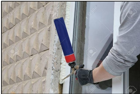
Fig 109 Utilisation de PU pour les fenêtres source http://spbterem.ru/mousse-expansive-isolation-fenetre/ https://fr.123rf.com/photo_52824453_la-main-de-travailleur-fixer-une-fen%C3%AAtre-en-utilisant-la-mousse-de-polyur%C3%A9thane.html
