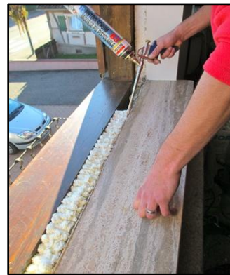
Fig 109 Utilisation de PU pour les fenêtres source http://spbterem.ru/mousse-expansive-isolation-fenetre/ https://fr.123rf.com/photo_52824453_la-main-de-travailleur-fixer-une-fen%C3%AAtre-en-utilisant-la-mousse-de-polyur%C3%A9thane.html
