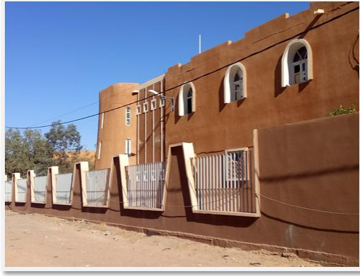
Fig 34 Photo d'un équipement actuelle de taghit ,source :auteur
