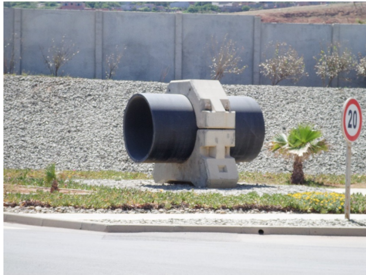
Figure V-3 : Conduite en PEHD, [source: MESLEK.F, Fouka 5/2014 ].
