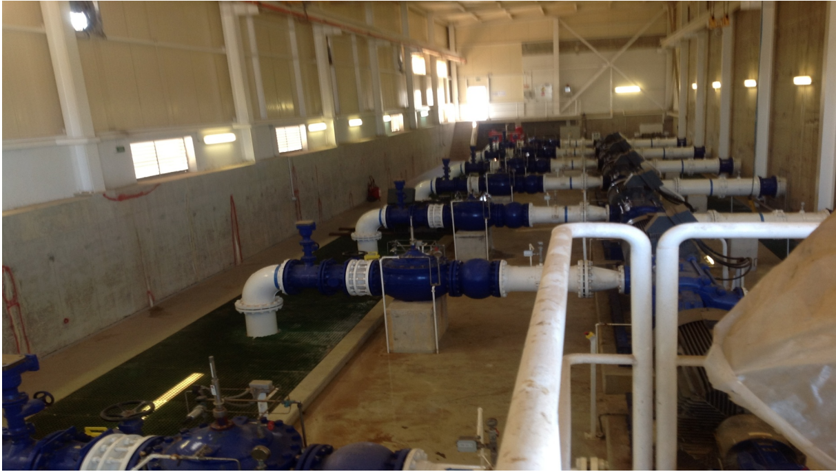
Figure V-14 : Station de pompage d'eau traitée, [source: MESLEK.F].
