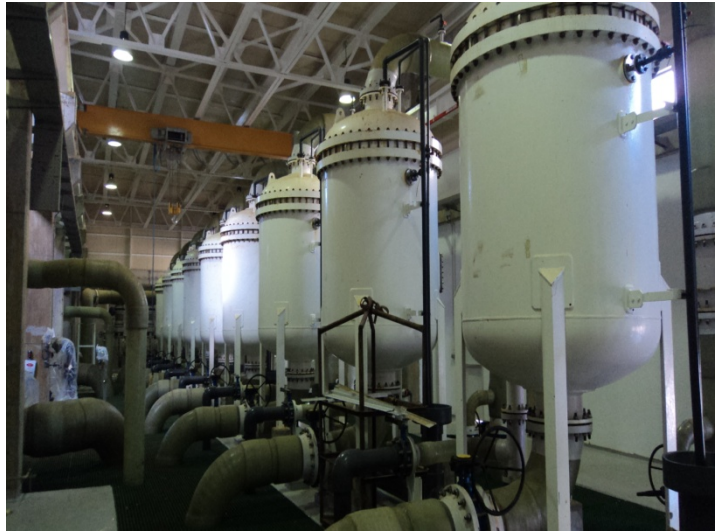
Figure V-7 : L'unité des filtres à cartouches, [ source: MESLEK.F].
