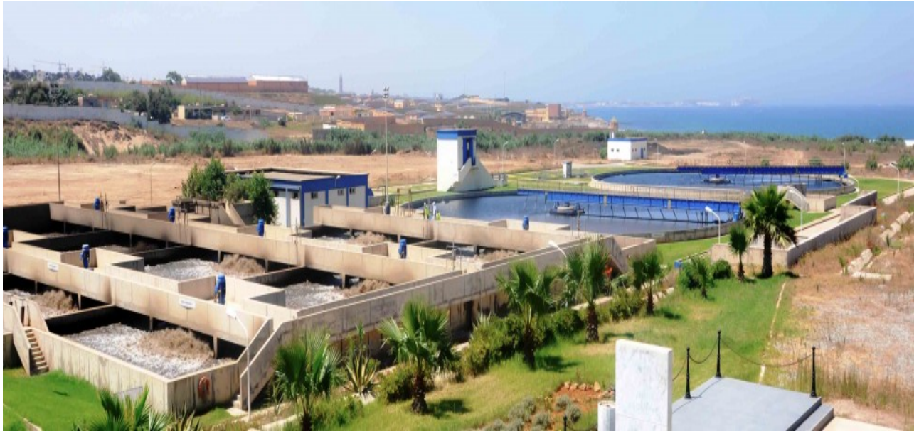
Figure. IV.1 : photographie de la station d'épuration des eaux usées résiduelles de Béni-Messous. [76]
