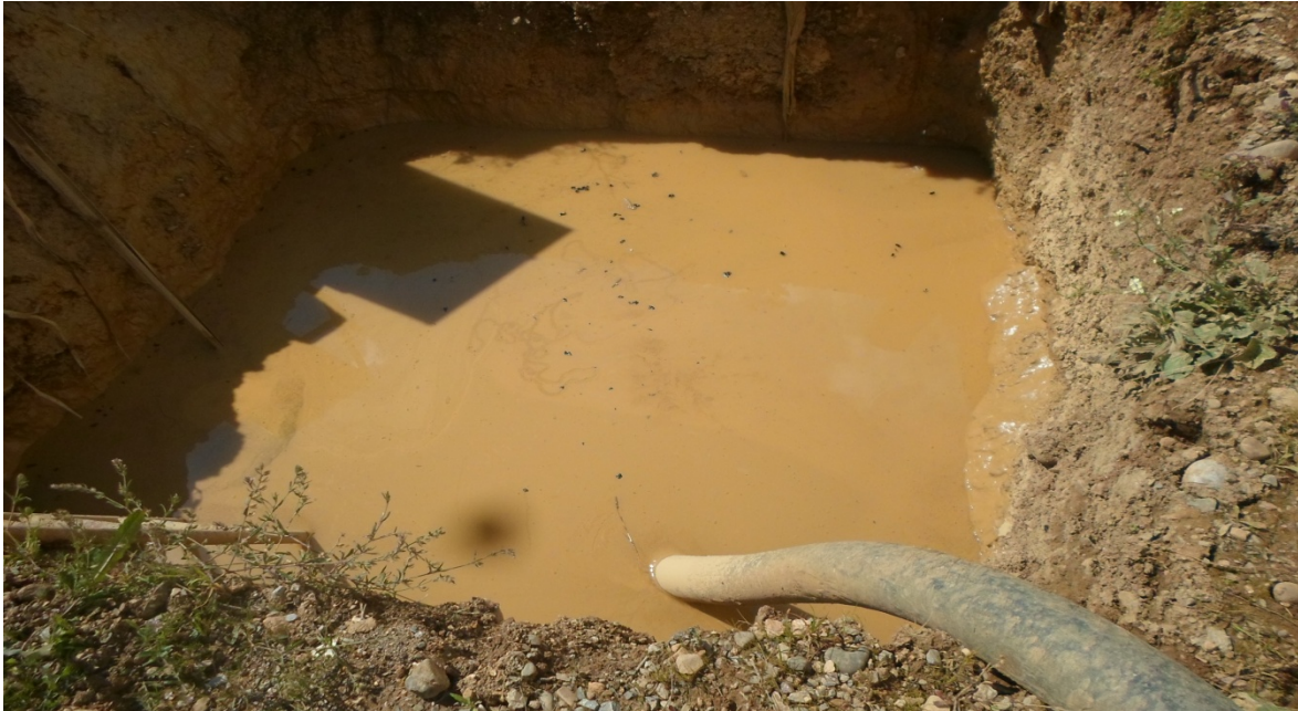
Figure IV.4 : Bassin de décantation
