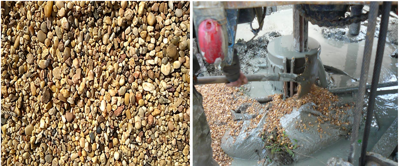
FigureIV.8 : Massif de gravier et la mise en place
