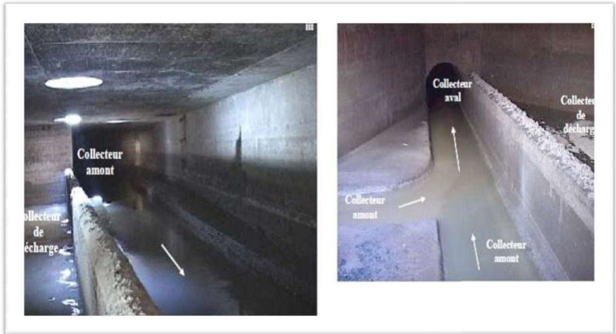
Figure VIII.02 : Exemple de déversoir d'orage.
