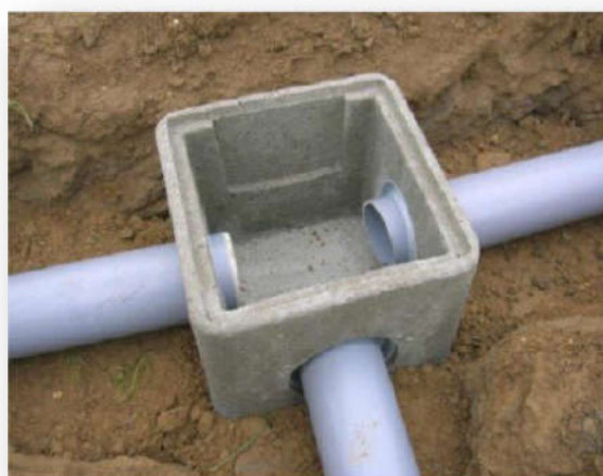
Figure IV.15 Regard de changement de diamètre.
