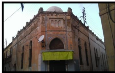
Figure 40 : Synagogue SOURCE : prise par l'auteur
