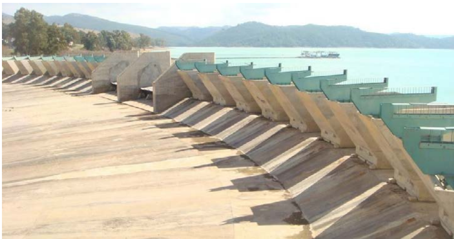
Figure1.8 : Surélévation du barrage Ghrib par des hausses fusibles [17].
