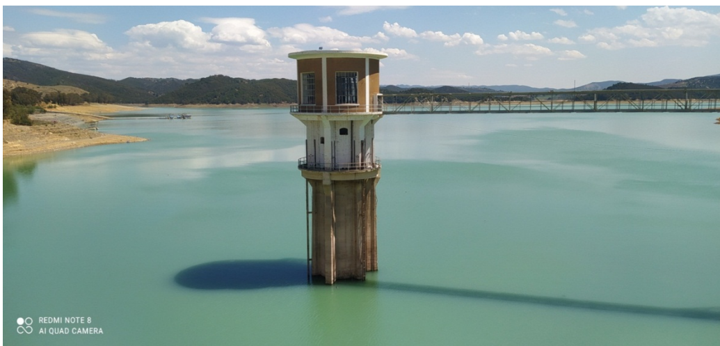
Figure 3.1 : Tour de prise du barrage Ghibri (Photo : S. Ghecham 20 Avril 2021).
