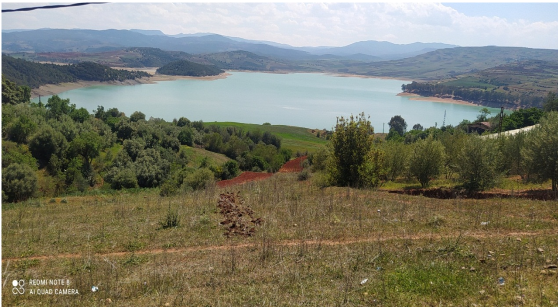
Figure 3.3 : Retenue du barrage Ghrib (Photo : S. Ghecham 20 Avril 2021).
