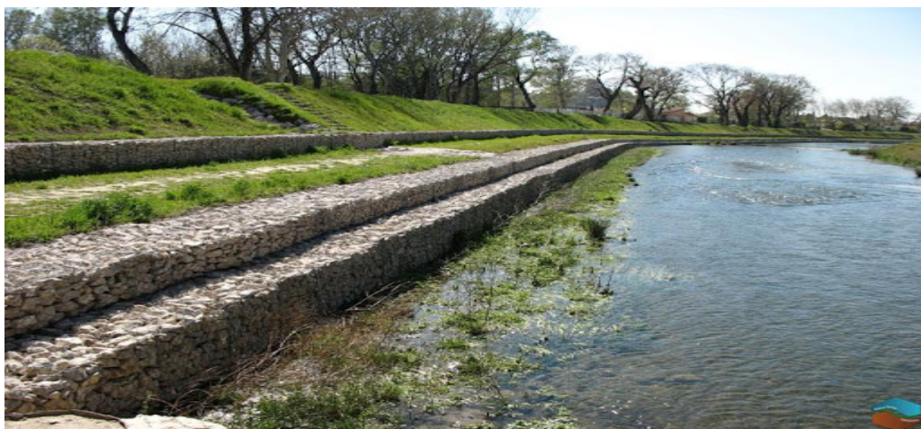
Figure 1.4 : protection des berges par les gabions [15].
