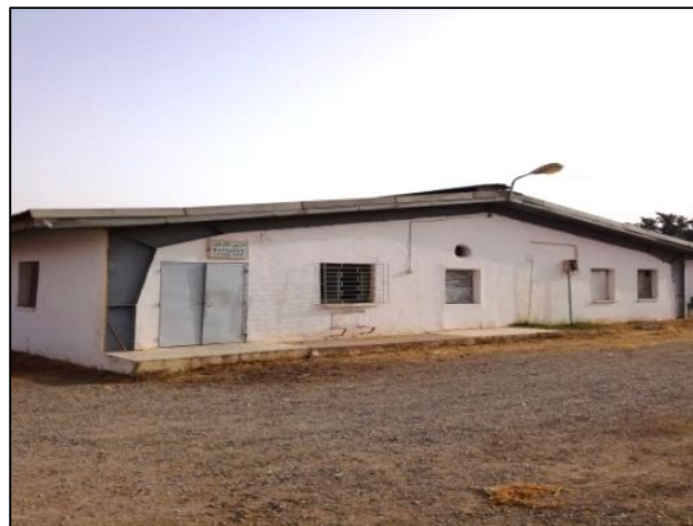
Figure 10 : Bâtiment d'élevage canicule (photo personnelle).
