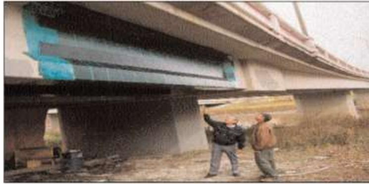
Figure I.2. Application du TFC sur un tablier de pont à poutres.
