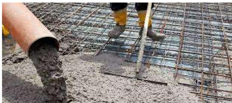
Figure I.3. Confection de béton pour dalle
