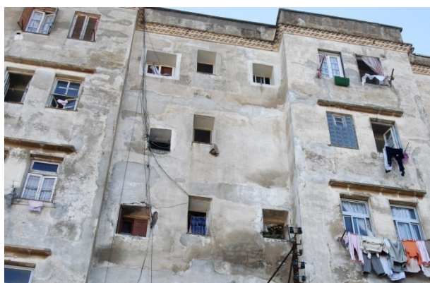
Figure. 4.10 : Ouvertures percées sur la façade du bloc (A). Figure. 4.11 : Type de modifications apportées sur la façade.
