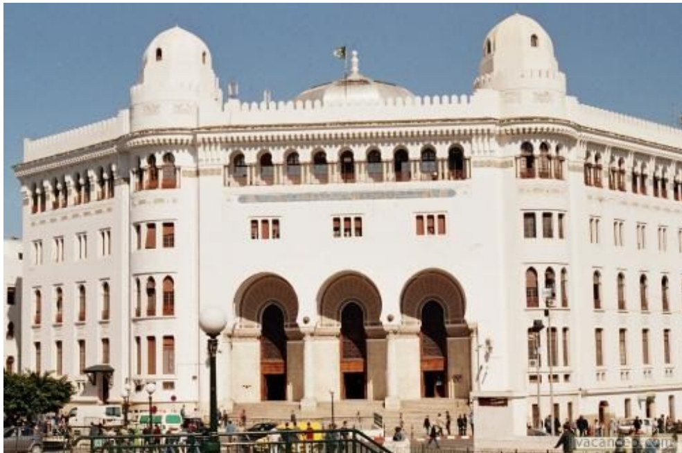
Figure. 1.3 : La grande Poste, Voinot et Tondoire, 1910.
