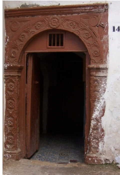
Figure. 3.24 : Les arcs outrepassés de la galerie d'une maison de la Casbah. Figure. 3.25 : L'arc plein cintre du chambranle de la porte d'entrée d'une maison de la Casbah.
