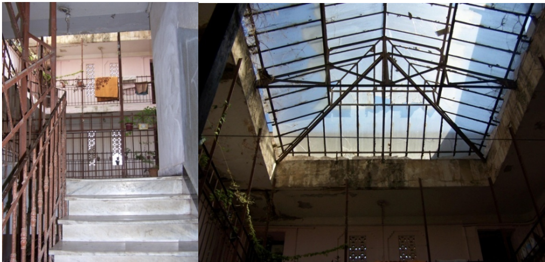
Figure. 4.44 : Vue sur la cour depuis les escaliers. Figure. 4.45 : Vue en contre plongée sur la verrière.
