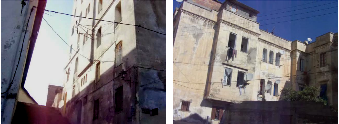
Figure. 4.33 : Façade latérale sur la rue Ramon Rull. Figure. 4.34 : Façade du bloc (B) et (C) sur la rue des Maugrebins.
