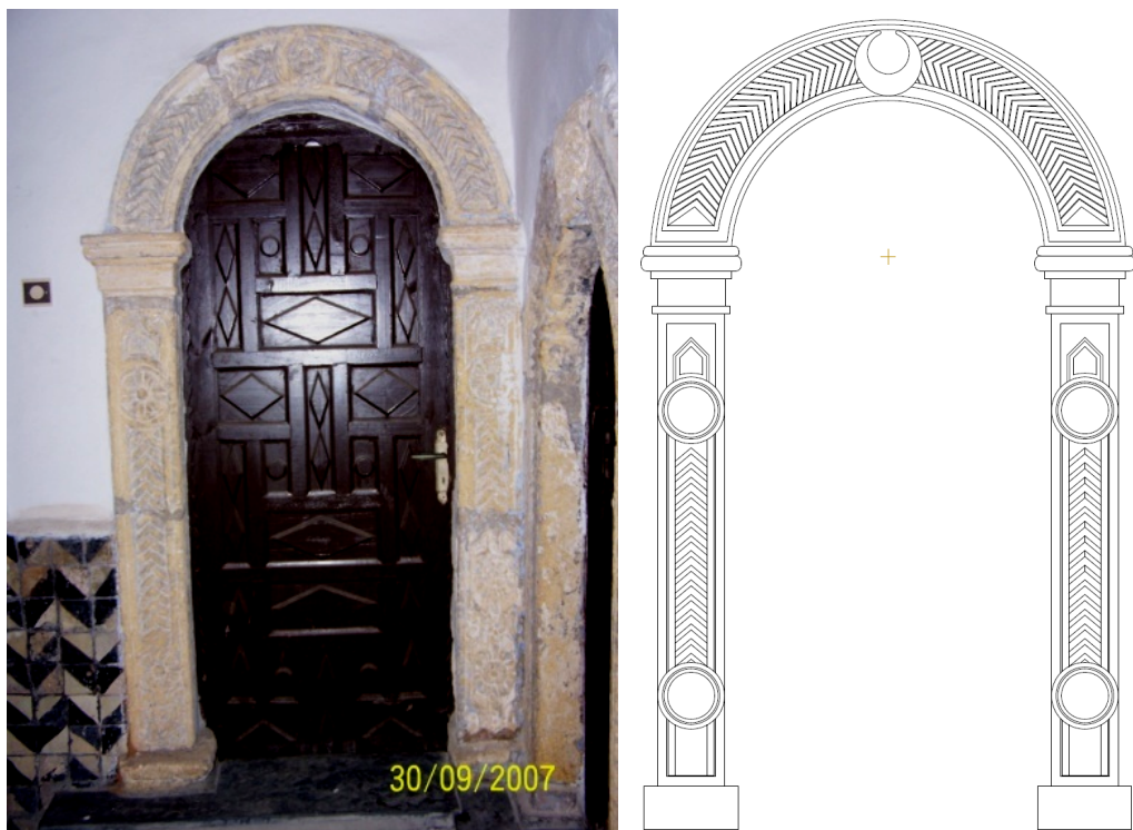
Figure. 5.29 : Porte du débarras.
