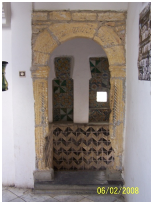
Figure. 5.30 : Porte de la sortie de l'escalier vers l'étage.
