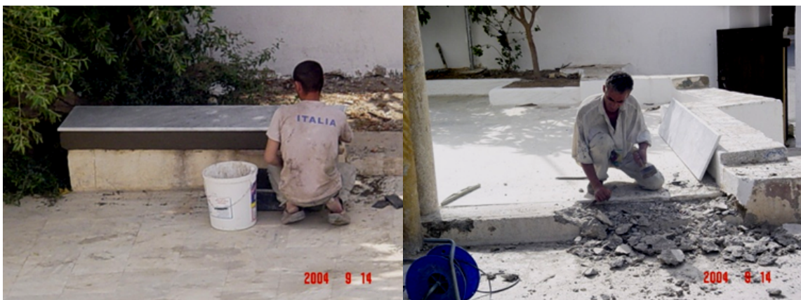
Figure. 5.8 & 5.9 : Remplacement du schiste des bancs.
