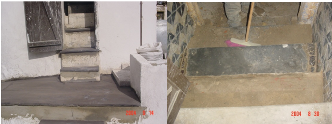
Figure. 5.6 & 5.7 : Remplacement du schiste des escaliers.
