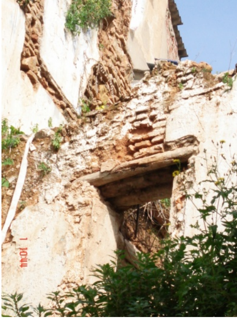
Figure. 3.6 : Structure apparente des murs d'une maison de la Casbah. Figure. 3.7 : Lits de pierres et de briques composants un mur de l'une des maisons de la Casbah.
