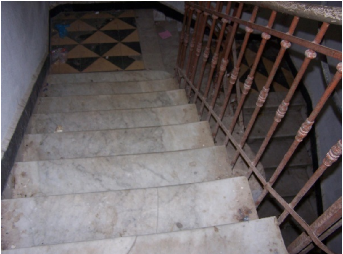
Figure. 4.47 : revêtement des sols et escaliers.
