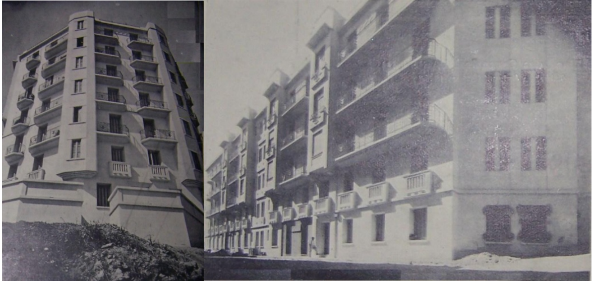
Figure. 2.5 : Les HBM du chemin Bobillot, immeubles B et C, Arch. A. Ramalli et M. Fankhauser [16].
