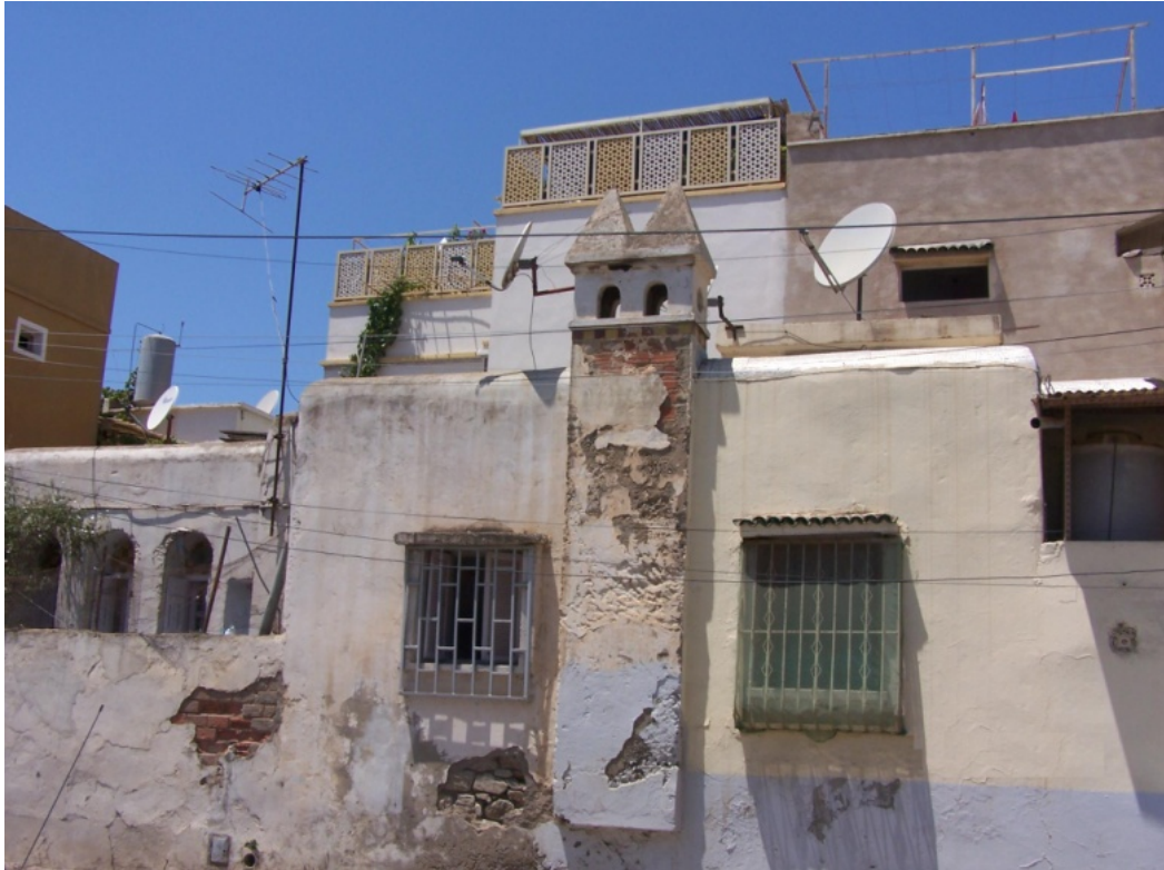
Figure. 2.15 : Façade actuelle de l'une des maisons de Scala de Clos Salembier.
