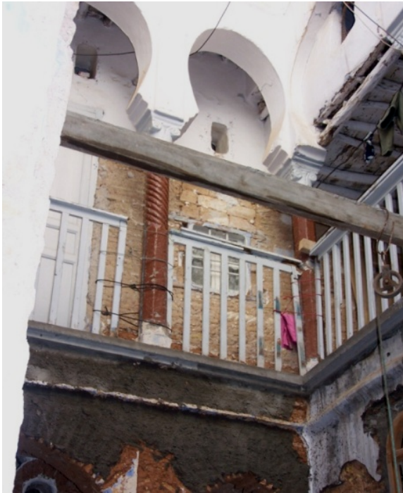
Figure. 3.24 : Les arcs outrepassés de la galerie d'une maison de la Casbah. Figure. 3.25 : L'arc plein cintre du chambranle de la porte d'entrée d'une maison de la Casbah.
