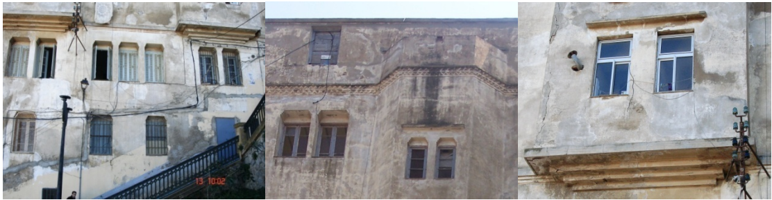
Figure. 4.36 : Les fenêtres à arc en tas de charges et rectangulaires.
