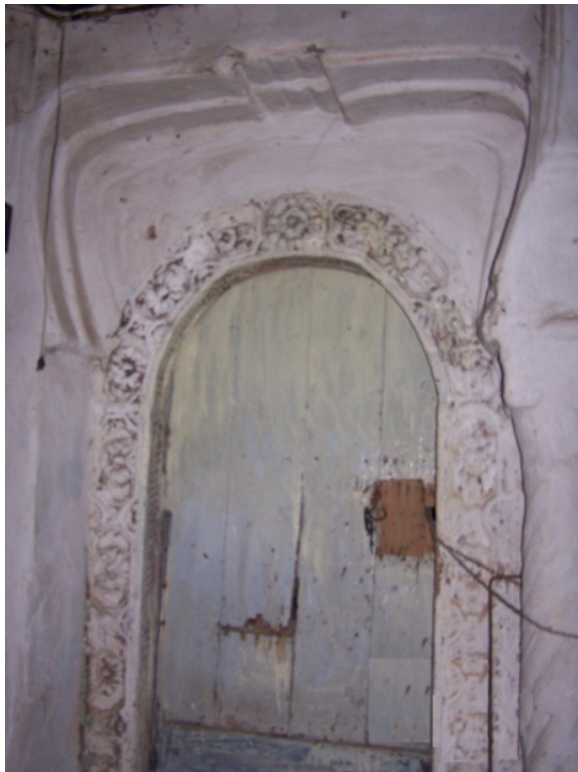
Figure. 3.26 : L'arc en accolade surmontant une porte d'intérieur cintrée. Figure. 3.27 : Colonne demi-torsadée d'une maison de la Casbah.
