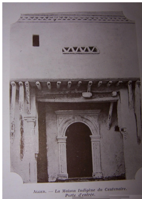
Figure. 5.3 : Ancienne photo de la porte d'entrée [16].
