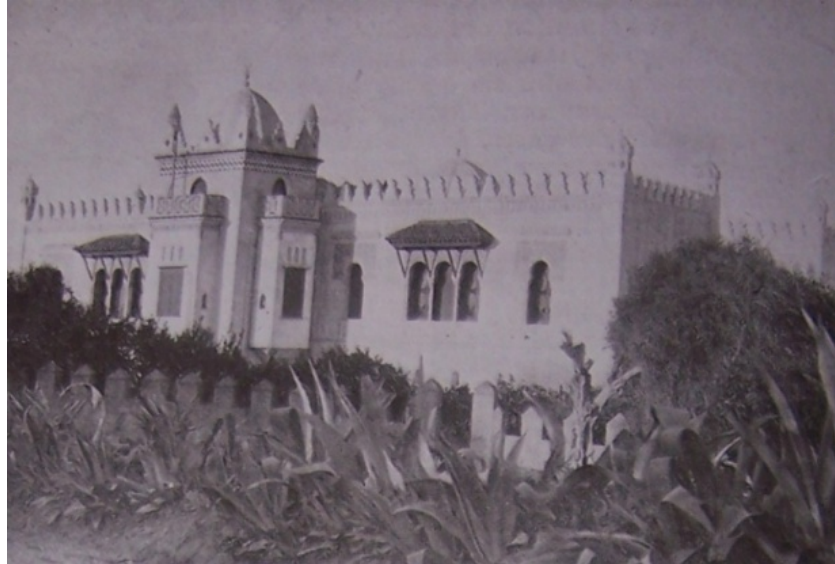
Figure. 1.12 : Villa Sésini (actuellement Consulat d'Allemagne). Mise en valeur des coupoles, des merlons et des auvents. Cheminées semi-monumentales aux angles des terrasses [10].
