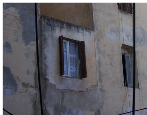
Figure. 4.10 : Ouvertures percées sur la façade du bloc (A). Figure. 4.11 : Type de modifications apportées sur la façade.
