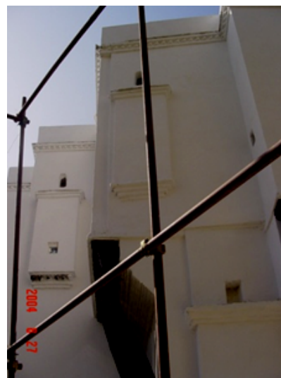
Figure. 5.10 : Revêt des murs extérieurs avec du mortier de chaux. Figure. 5.11 : Echafaudage de la bâtisse lors des travaux.
