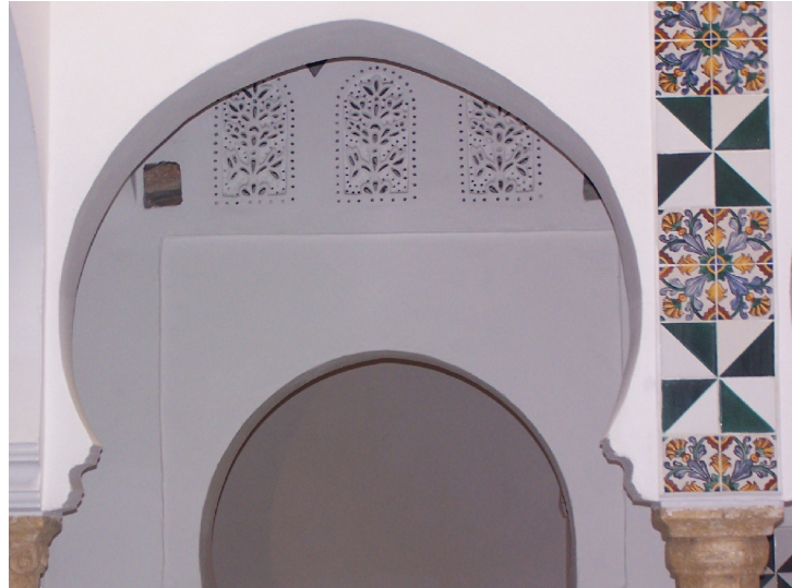
Figure. 3.28 : Claustras de plâtre surmontant une porte (Bastion 17).
