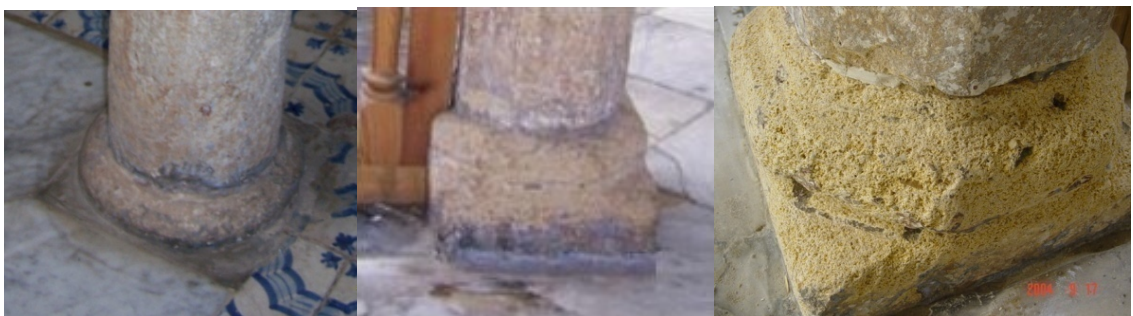
Figures. 5.43, 5.44 & 5.45 : Les trois types de bases des colonnes des deux galeries.
