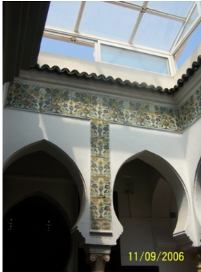
Figure. 5.14 : La verrière installée au dessus du patio.
