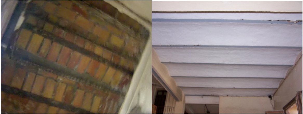
Figure. 4.46 : Plancher avec voutines en briques.
