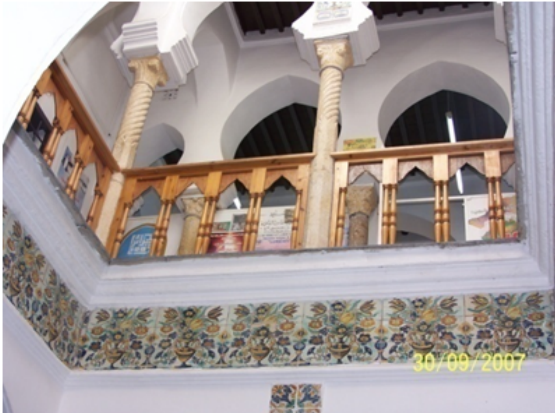
Figure. 5.48 : Vue en contre plongée de la balustrade.
