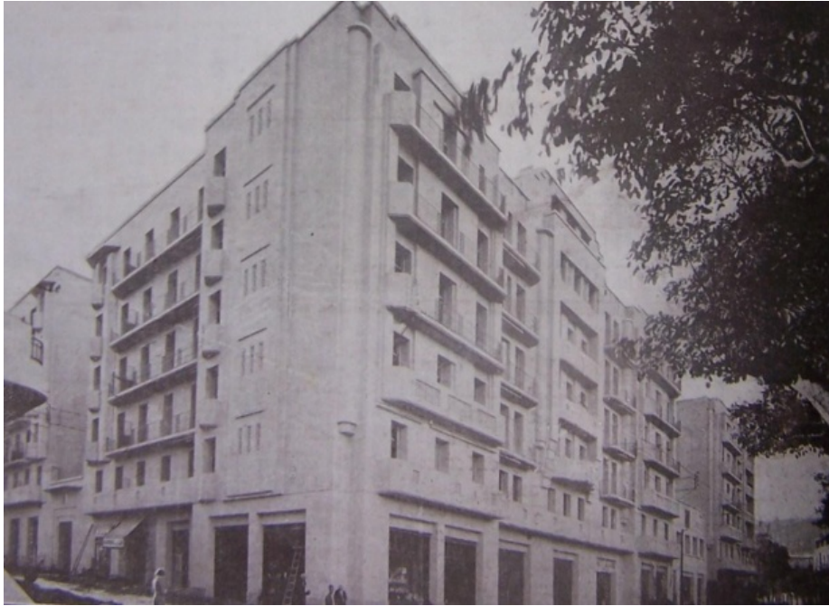
Figure. 2.6 : Deux aspects des immeubles érigés sur le Champ de manœuvre (1 er îlot), Arch. X. Salvador. Bâtiments construits en forme de bandes, larges de 10m.50. Les accès des escaliers sont disposés dans de vastes cours intérieures agrémentées de jardins [16].
