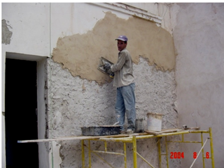
Figure. 5.10 : Revêt des murs extérieurs avec du mortier de chaux. Figure. 5.11 : Echafaudage de la bâtisse lors des travaux.
