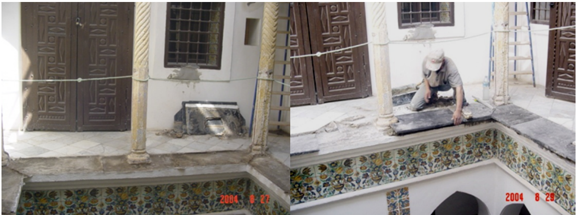
Figure. 5.4 & 5.5 : Remplacement du schiste de la galerie.
