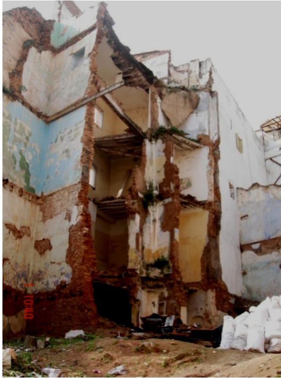
Figure. 3.3 : Ossature d'un immeuble de la Casbah.
